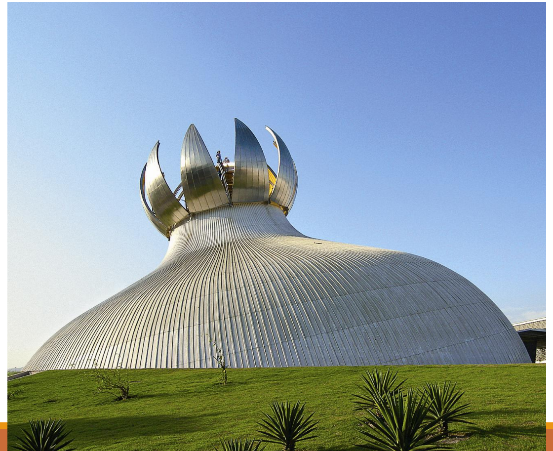
IMAGEM 1 – Rede Sarah, Rio de Janeiro; do arquiteto João Filgueiras Lima, o Lelé.
